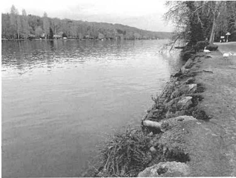
Tronçon amont (30m)
